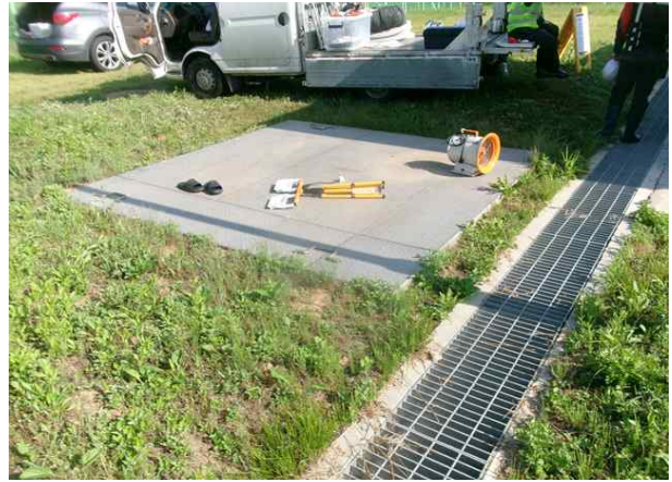
장비 반입구 덮개 현황
