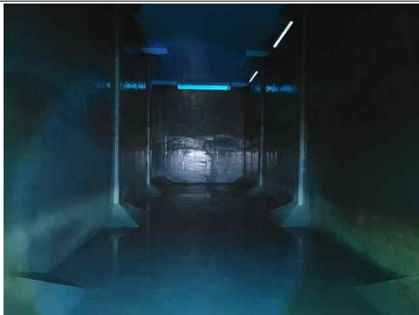
배수지 1지 내부 전경
