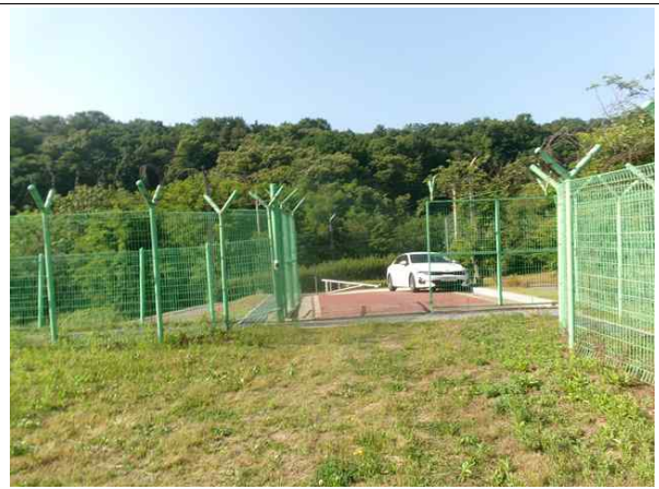
진입로 포장 전경
