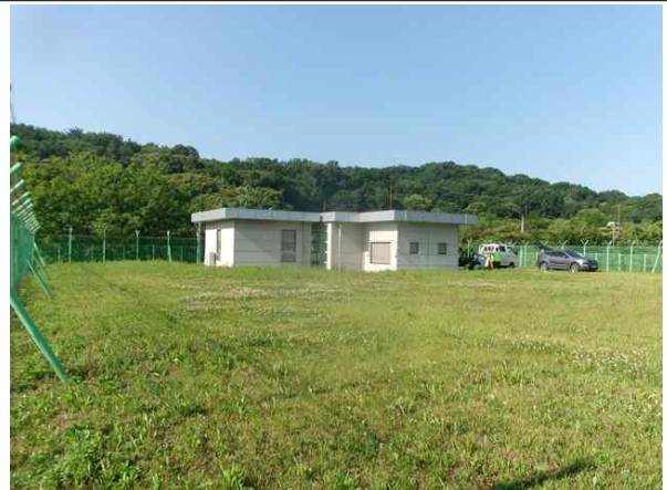
배수지 상부 현황
