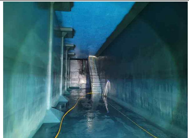
배수지 2지 내부 전경
