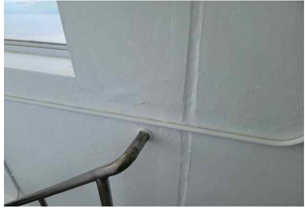
손상내용 검수실 내부 벽체 균열 손상원인 건조수축, 온도변화
